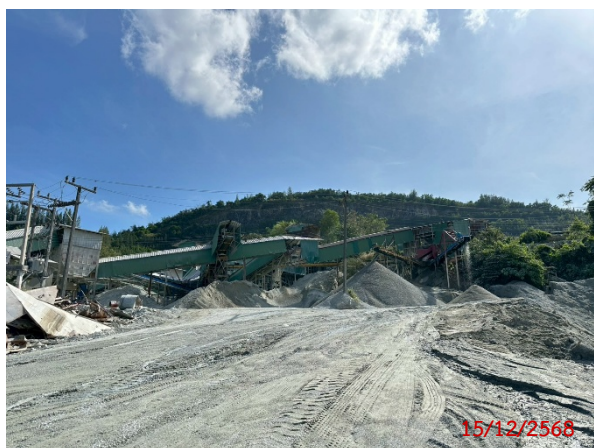
ภาพที่ 2-12 การปิดคลุมโรงโม่ และระบบสเปรย์น้ำป้องกันฝุ่นละอองบริเวณโรงโม่หินของโครงการ
